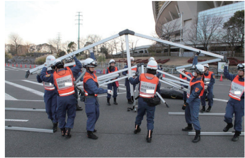
リフトアップテントの設営①
